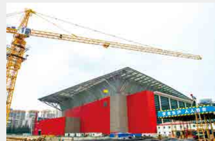
博览中心三期工程现场图
